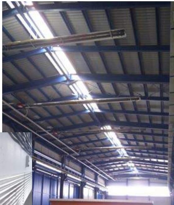
Za potrebe grijanja hale ugrađeni su plinski uređaji Fraccaro serije Panrad, te toplovodni grijajući paneli serije WP istog proizvođača. Kod oba sustava radi se o grijanju na principu isijavanja topline.
