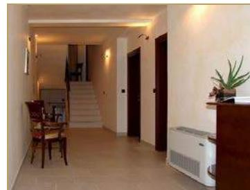
Za potrebe grijanja i hlađenja objekta ugrađena je Aermec-ova dizalica topline serije ANL i ventilatorski konvektori serije FCX U i FCL istog proizvođača.
