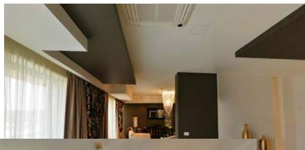
Unutar objekta ugrađeni su ventilatorski konvektori Aermec za visokozidnu ugradnju serije FCW, te kazetni ventilatorski konvektori serije FCA istog proizvođača.
