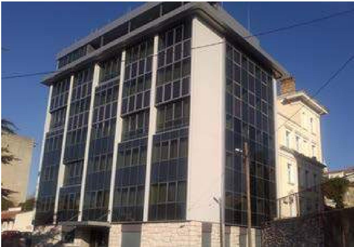
Zgrada sjedišta Primorsko goranske županije ima sedam etaža i ukupnu površinu od 1.800 četvornih metara. Na fasadi zgrade postavljene su fotonaponske celije za proizvodnju električne energije.
